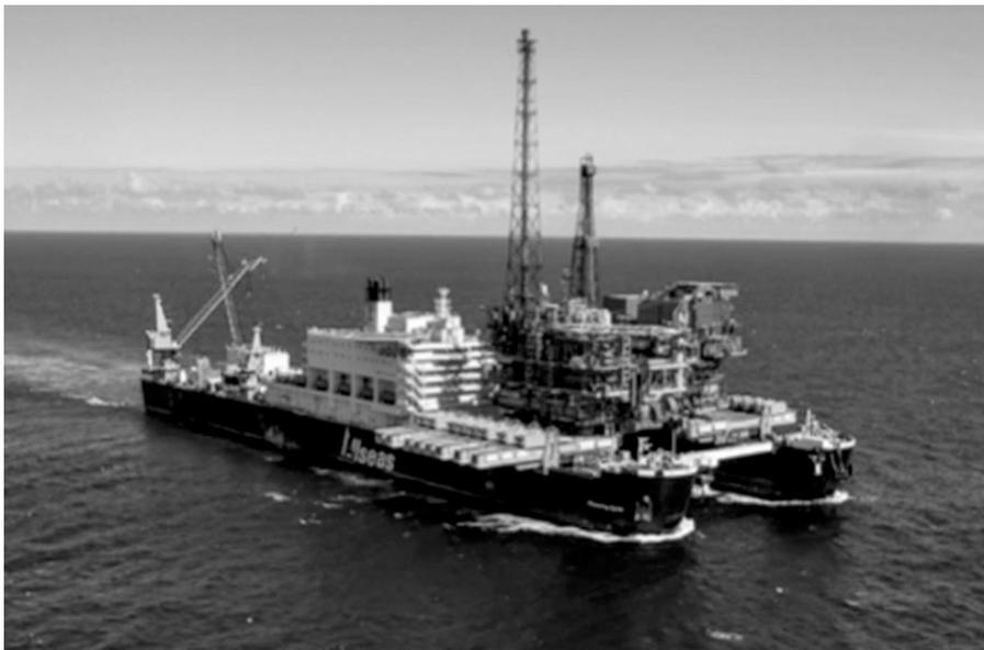
Abb. 5: Abbau der ersten Brent Plattform mit einem Gewicht von 23000 Tonnen, Mai 2016
